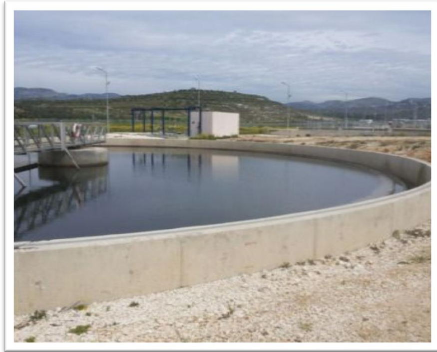
صورة تظهر وحدات الترسب النهائي
