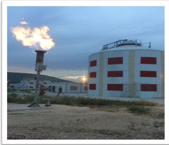
صورة تظهر الهاضم اللاهوائي وشعلة الغاز
