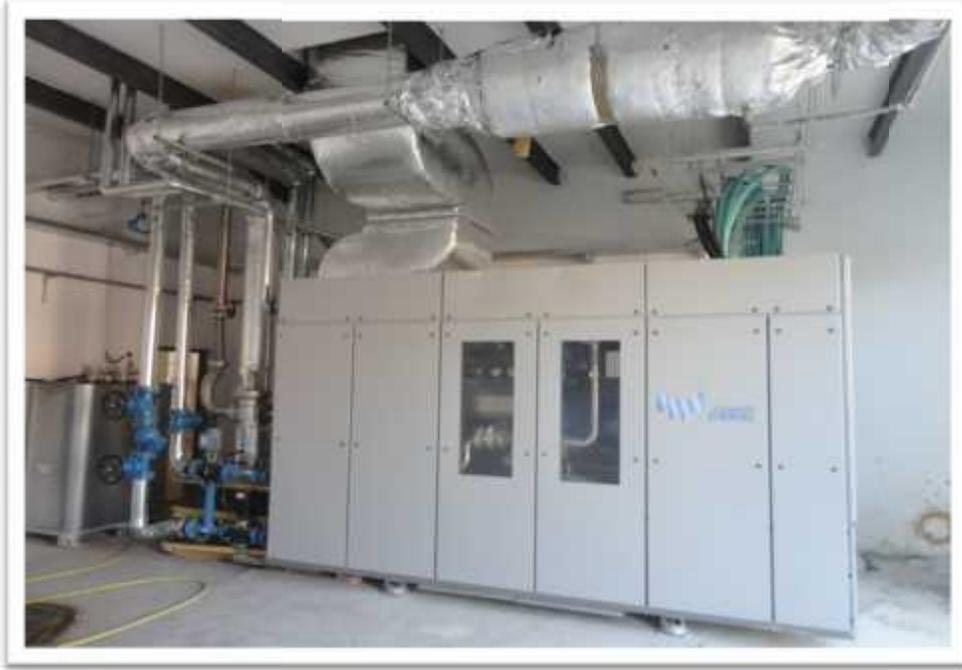
وحدة توليد الطاقة الكهربائية والحرارية
