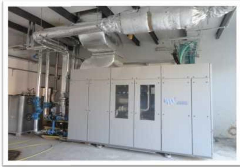
وحدة توليد الطاقة الكهربائية والحرارية
