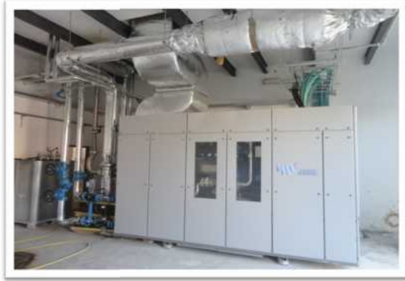
وحدة توليد الطاقة الكهربائية والحرارية
