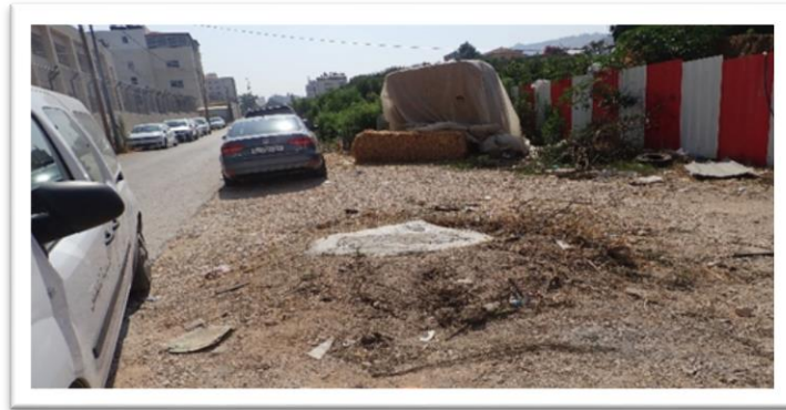
صورة رقم (25): صورة خطوط الصرف الصحي المكشوفة
