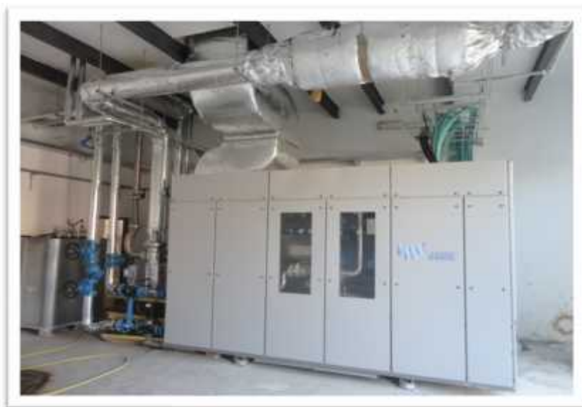
وحدة توليد الطاقة الكهربائية والحرارية
