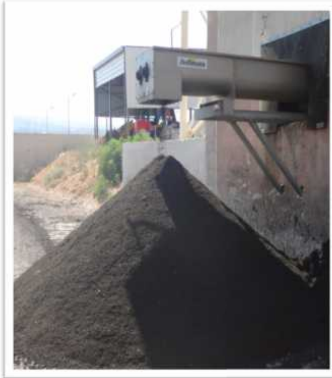
الحمأة الناتجة من وحدة عصر الحمأة
