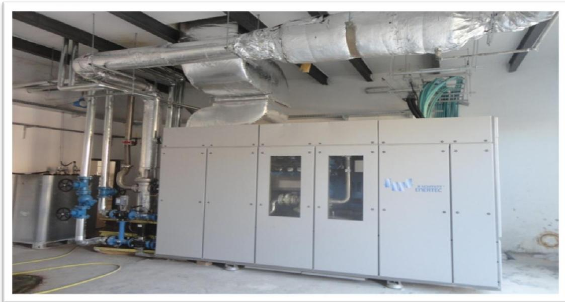
وحدة توليد الطاقة الكهربائية والحرارية
