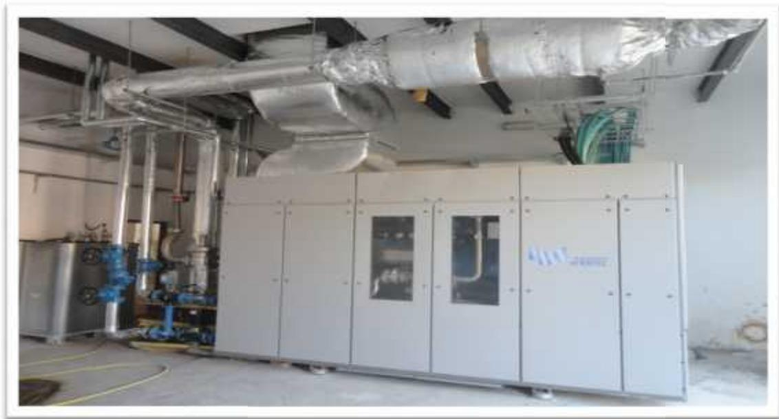
وحدة توليد الطاقة الكهربائية والحرارية
