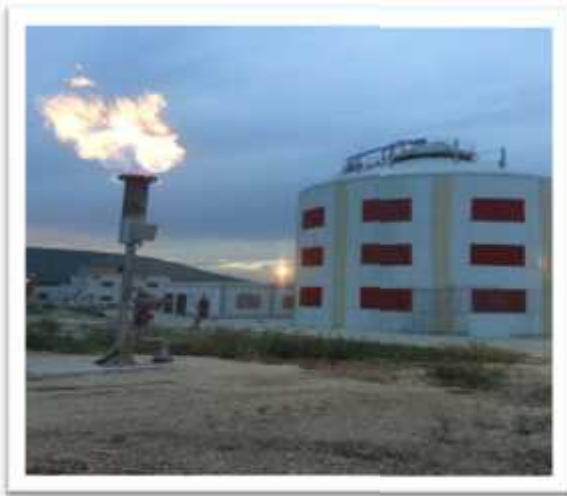
الهاضم اللاهوائي وشعله الغاز
