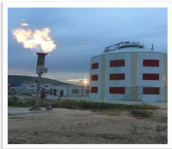
الهاضم اللاهوائي وشلعة الغاز
