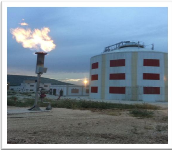
صورة تظهر الهاضم اللاهوائي وشعله الغاز
