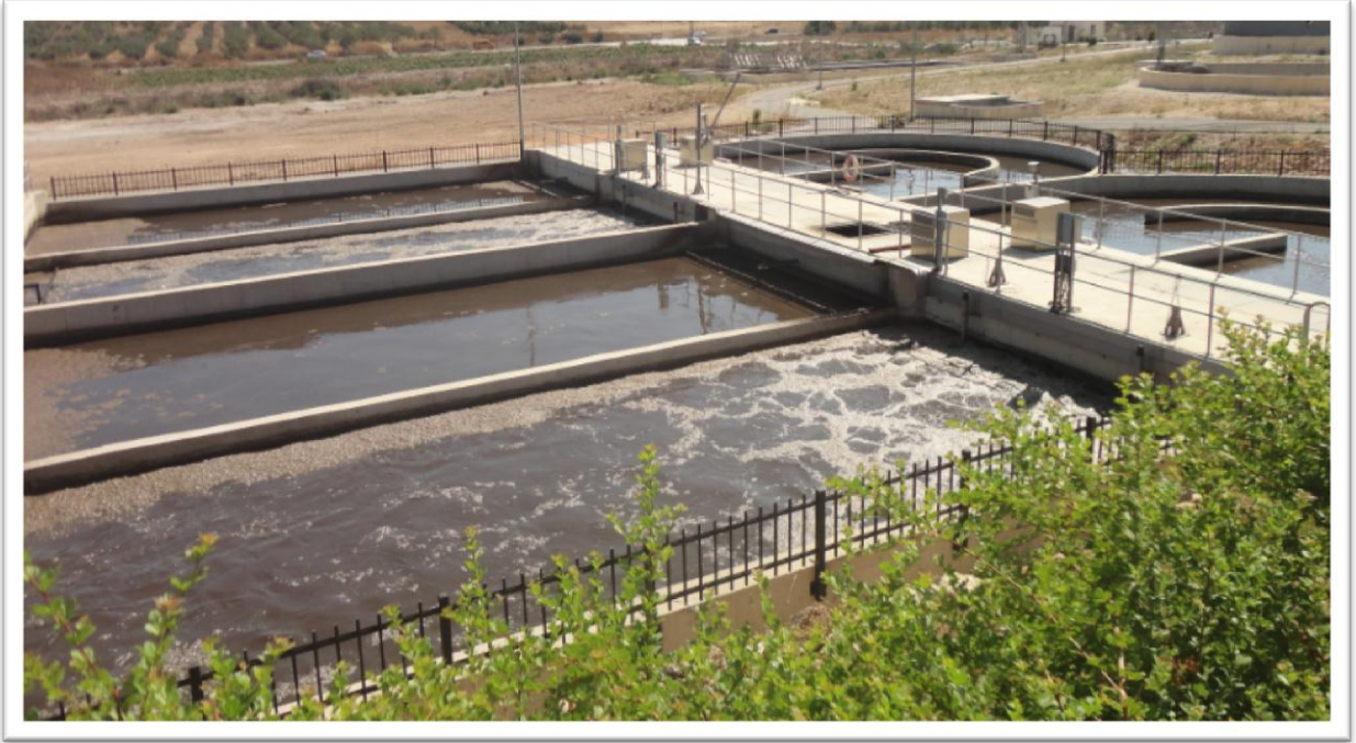
صورة تظهر وحدات التهوية
