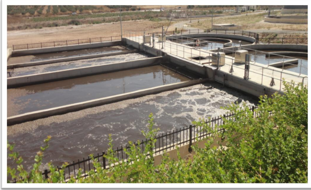
صورة تظهر وحدات التهوية
