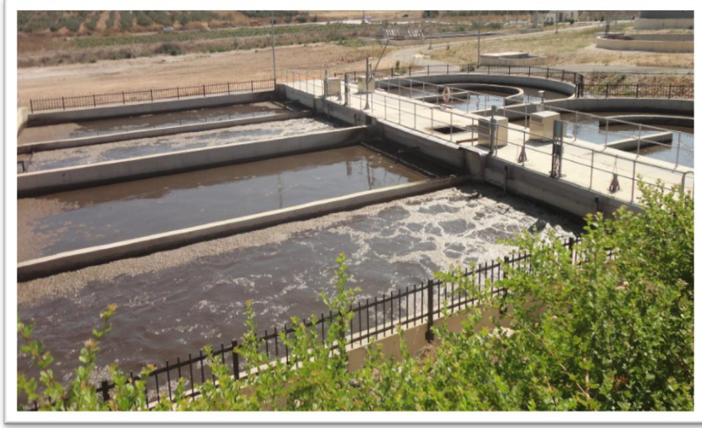
صورة تظهر وحدات التهوية
