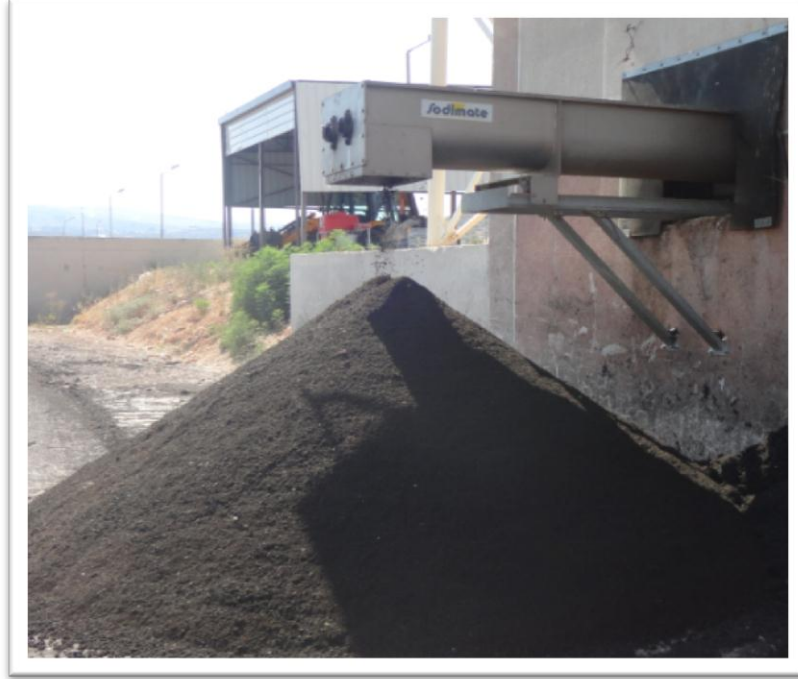
صورة تظهر الحمأة الناتجة من وحدات عصر الحمأة
