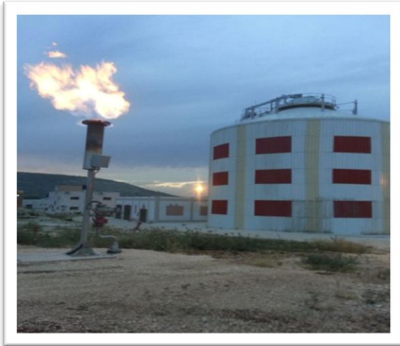
صورة تظهر الهاضم اللاهوائي وشلعة الغاز
